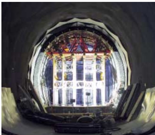
24 Betonieren des Innengewölbes im Übergangsbereich Abluftstollen/Abluftschacht
