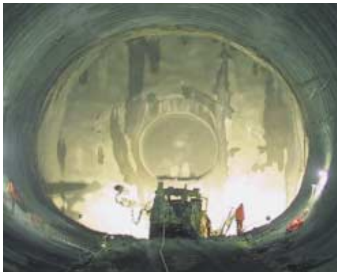
12 Montagekaverne für TBE und TBM 12 Assembly chamber for TBE and TBM
