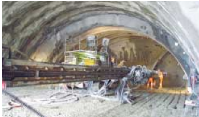
14 Rohrschirmeinbau in der Kalotte
