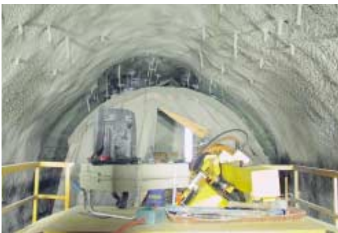
16 TBM-Vortrieb im Pilotstollen
