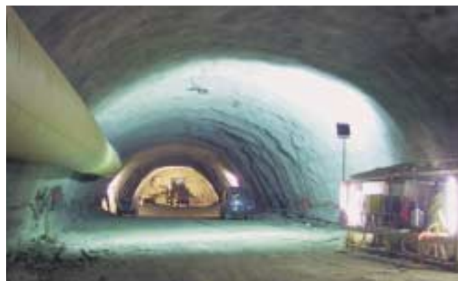
7 Kalottenvortrieb Molassestrecke Eichholz 7 Crown drive for the Eichholz molasse section
