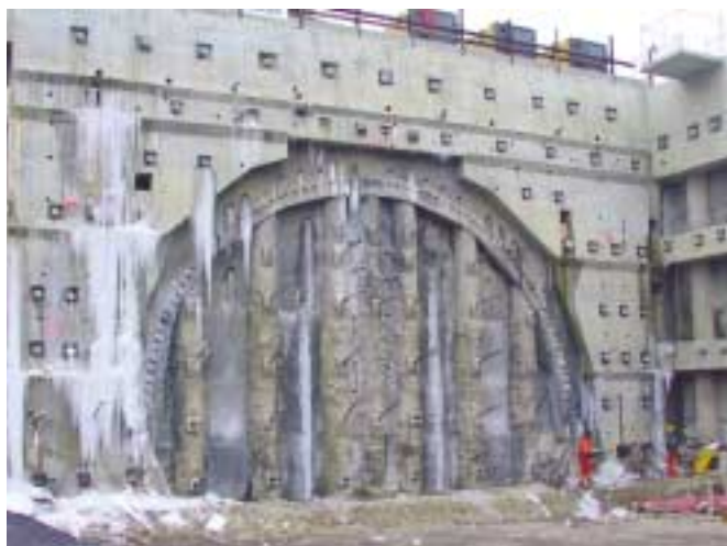
13 Portalansicht mit Rohrschirm 13 Portal view with pipe umbrella
