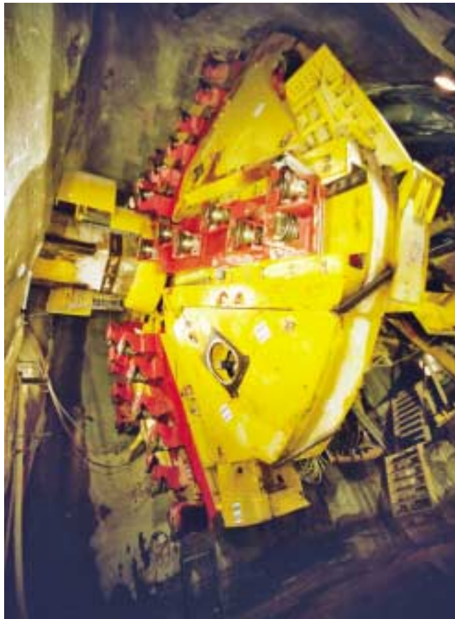
21 Montierter TBE-Bohrkopf in der Montagekaverne
