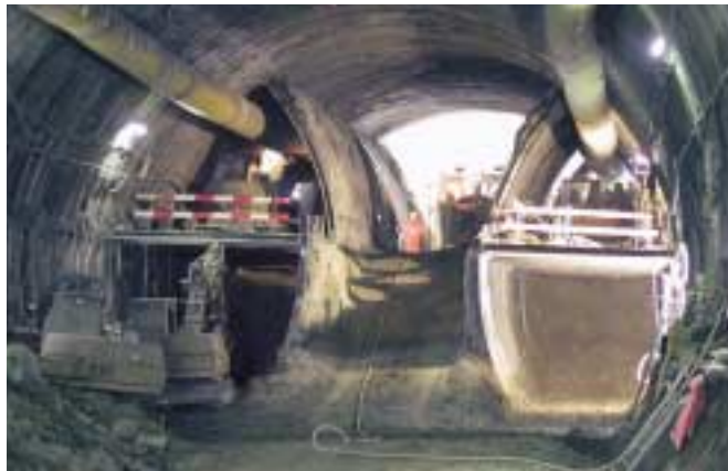
10 Kernbauweise (Vortrieb Lockergesteinsstrecke Diebis)
