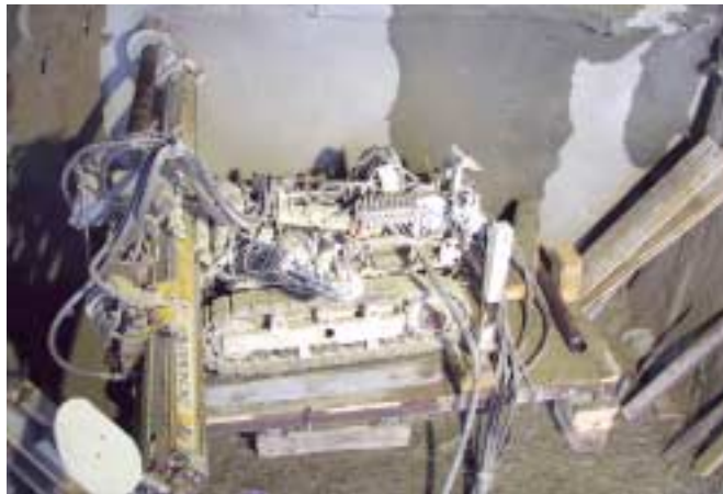
15 Bohrgerät im unteren Paramentstollen
