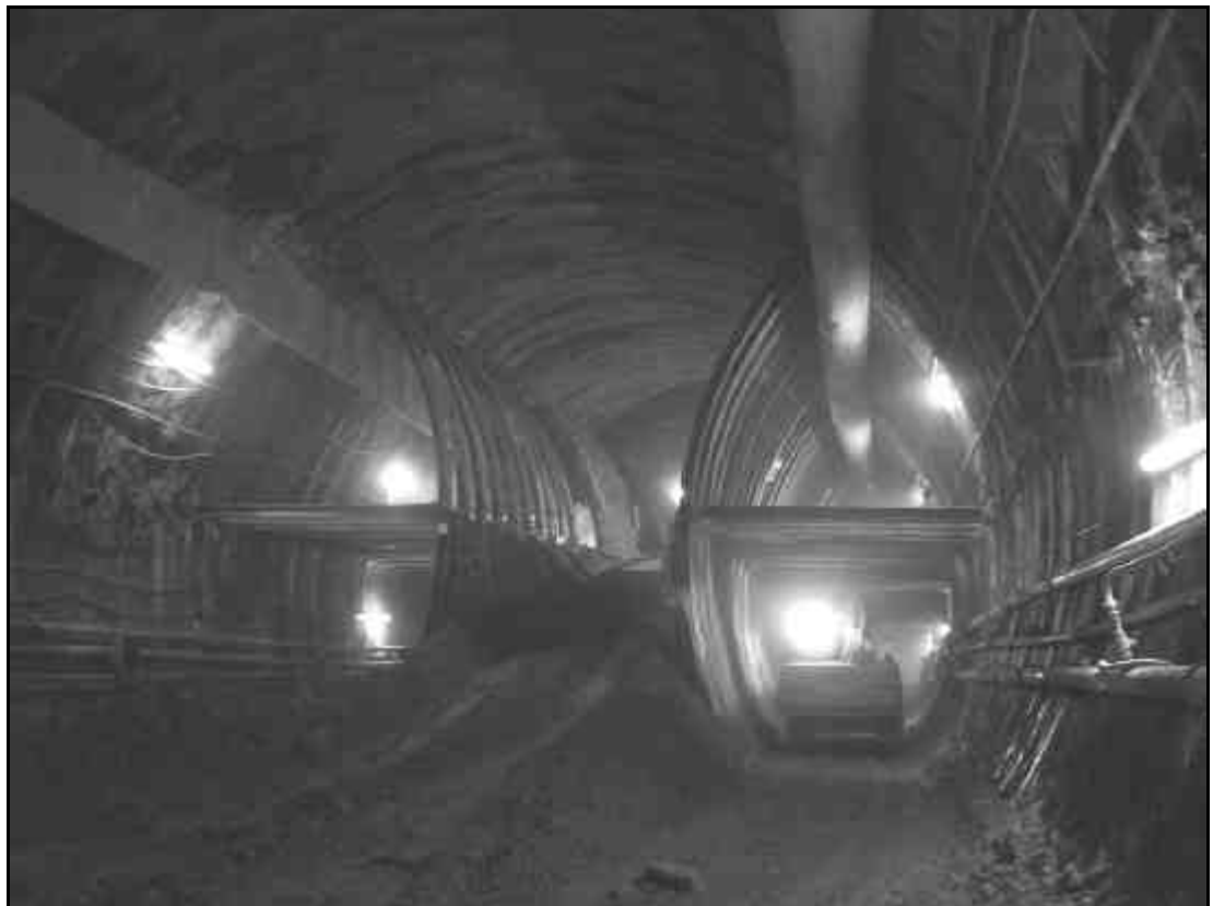
Kernbauweise (Vortrieb Lockergesteinsstrecke Diebis)
