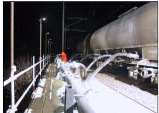
Zementumschlag ab Bahndamm
