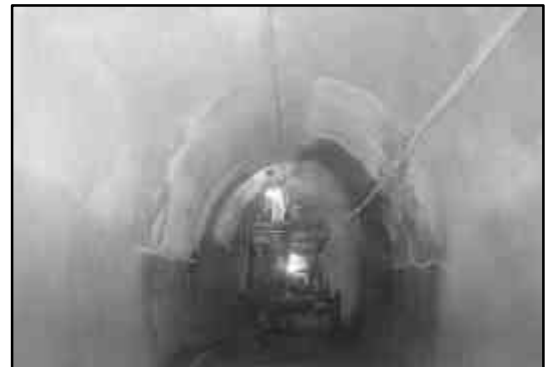
Verstärkungsarbeiten SBB-Tunnel
