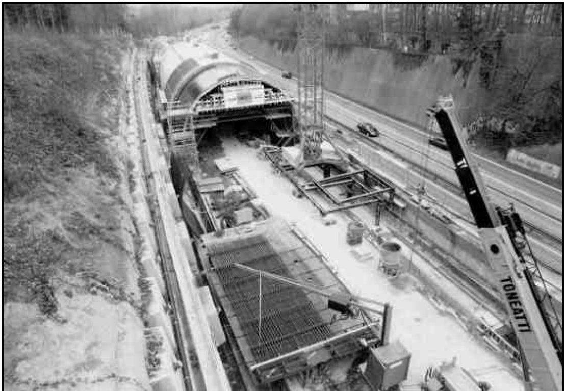
A3 Zürich-Chur, Überdeckung Entlisberg
