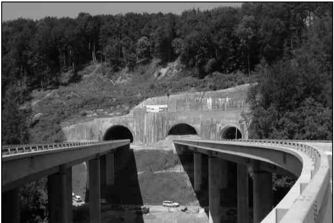
N20.1.4 Umfahrung Birmensdorf, Voreinschnitt Weiher mit Portalansicht Eggraintunnel und Ausfahrtstunnel Ristet (rechts) Im Vordergrund: Reppischtalbrücke
