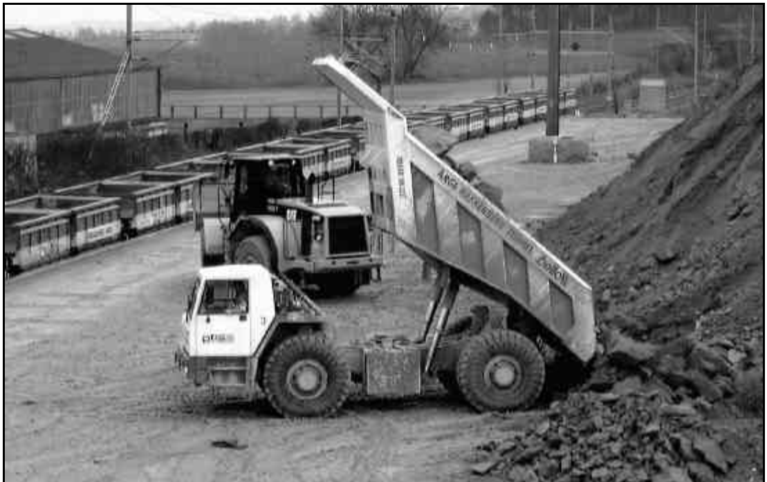
N4.1.20 Umfahrung Birmensdorf, Bahnverladeanlage Ristet
