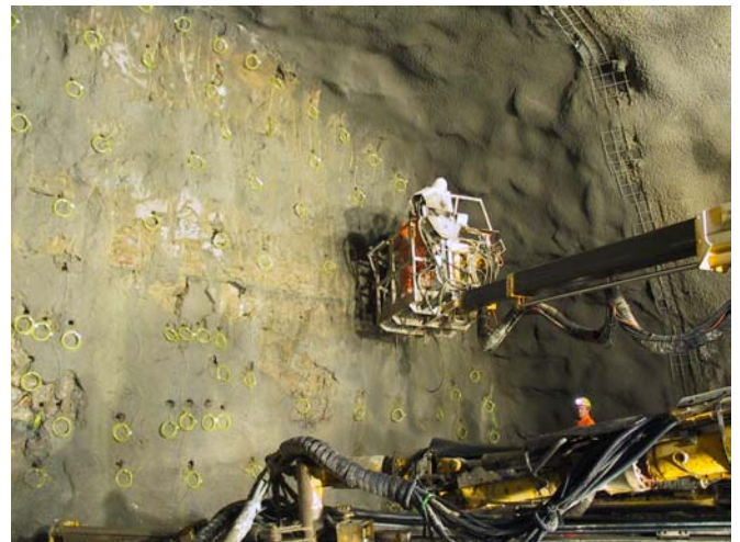
Vorbereitung der Sprengung Molassestrecke Eichholz
