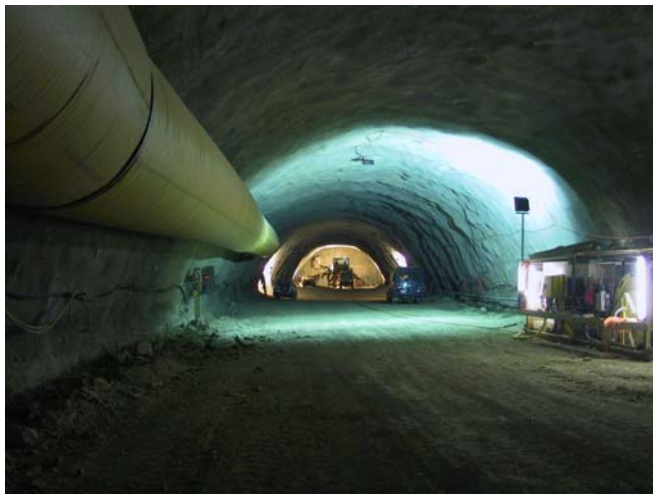
Kalottenvortrieb Molassestrecke Eichholz
