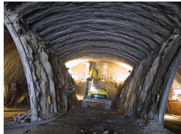
Vortrieb Kalotte im Lockergestein (LG-GJU)
