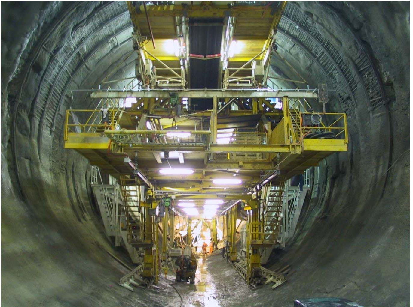
Blick unter dem TBE-Nachläufer Richtung Vortrieb
