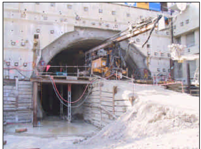
Portal Gänziloo (Zürich Brunau)
