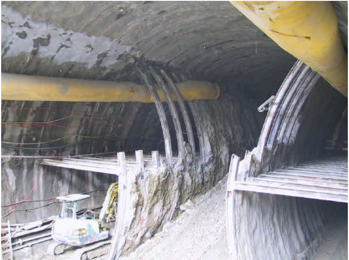
Vortrieb in Kernbauweise
