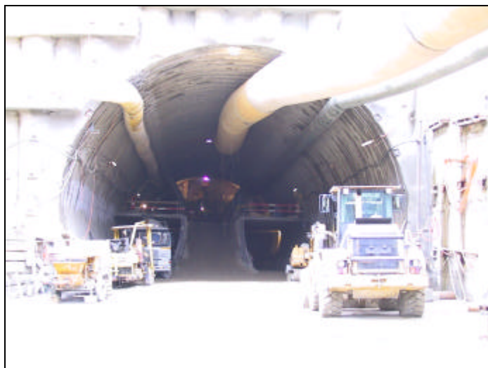
Bild N: Kernbauweise (Vortrieb Lockergesteinsstrecke Gjuch)
