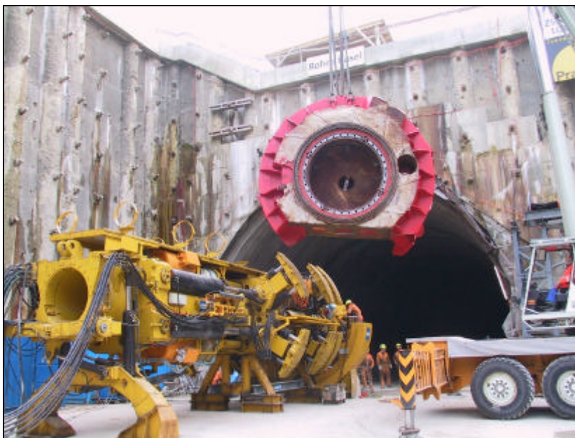
Bild U: Montage Pilot-TBM
