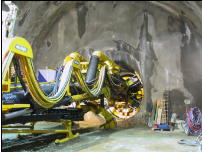
Bild O: Anfahren der Pilot-TBM (Durchmesser 5.0 m) in der Tunnelröhre Basel
