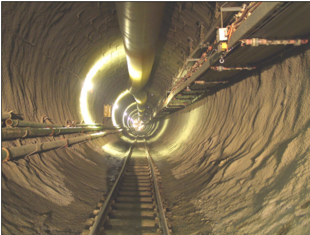
Bild V: Vortrieb Pilotstollen
