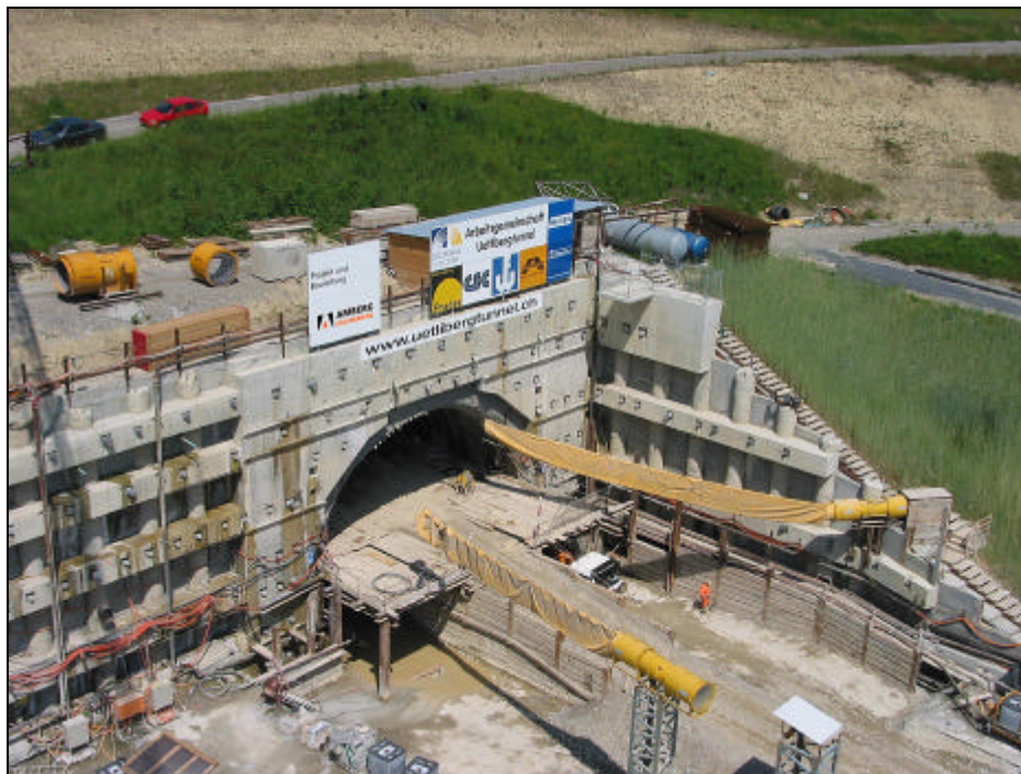
Bild J: Portalansicht Baugrube Gänziloo / Vortrieb Lockergesteinsstrecke Juchegg
