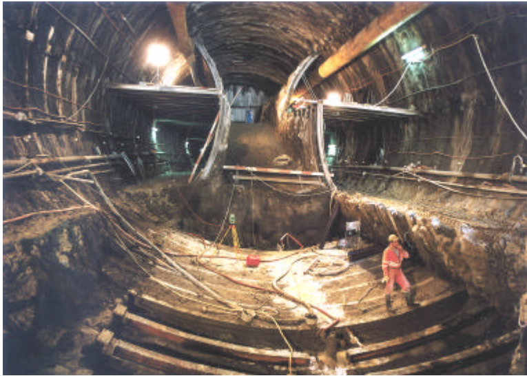
Bild R: Kernbauweise, Sohlbruch mit Ringschluss
