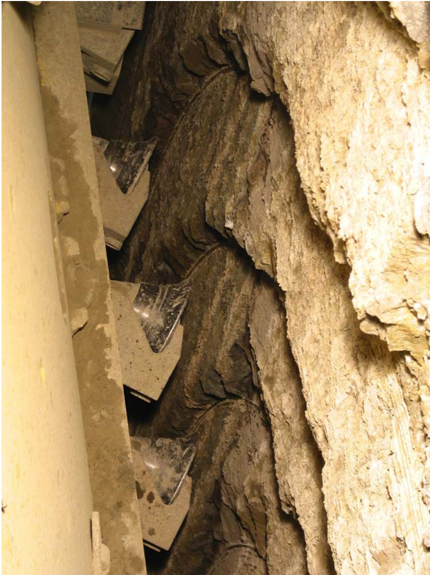
Bild 9: TBE-Bohrkopf beim Vorbeifahren an einer Querverbindung
