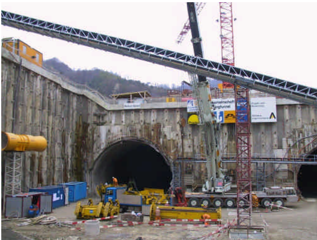
Bild O: Montage der Pilot TBM im April 02
