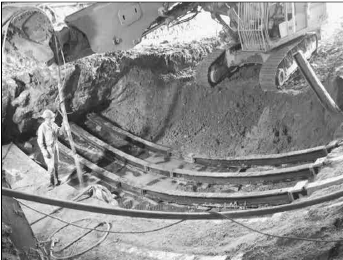
Bild L: Sohlausbruch mit Ringschluss
