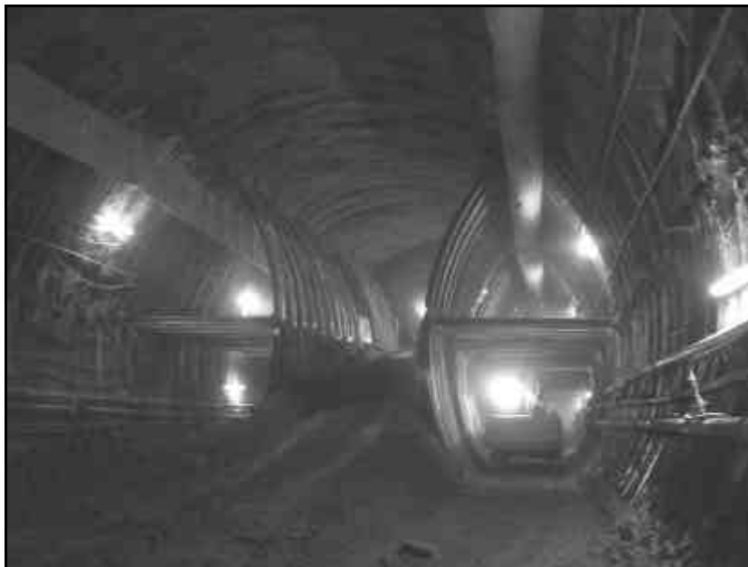
Bild I: Kernbauweise (Vortrieb Lockergesteinsstrecke Diebis)
