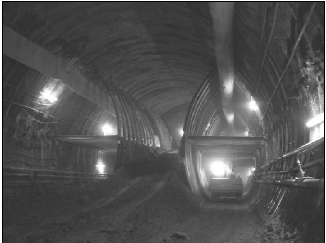
Kernbauweise (Vortrieb Lockergesteinsstrecke Diebis)
