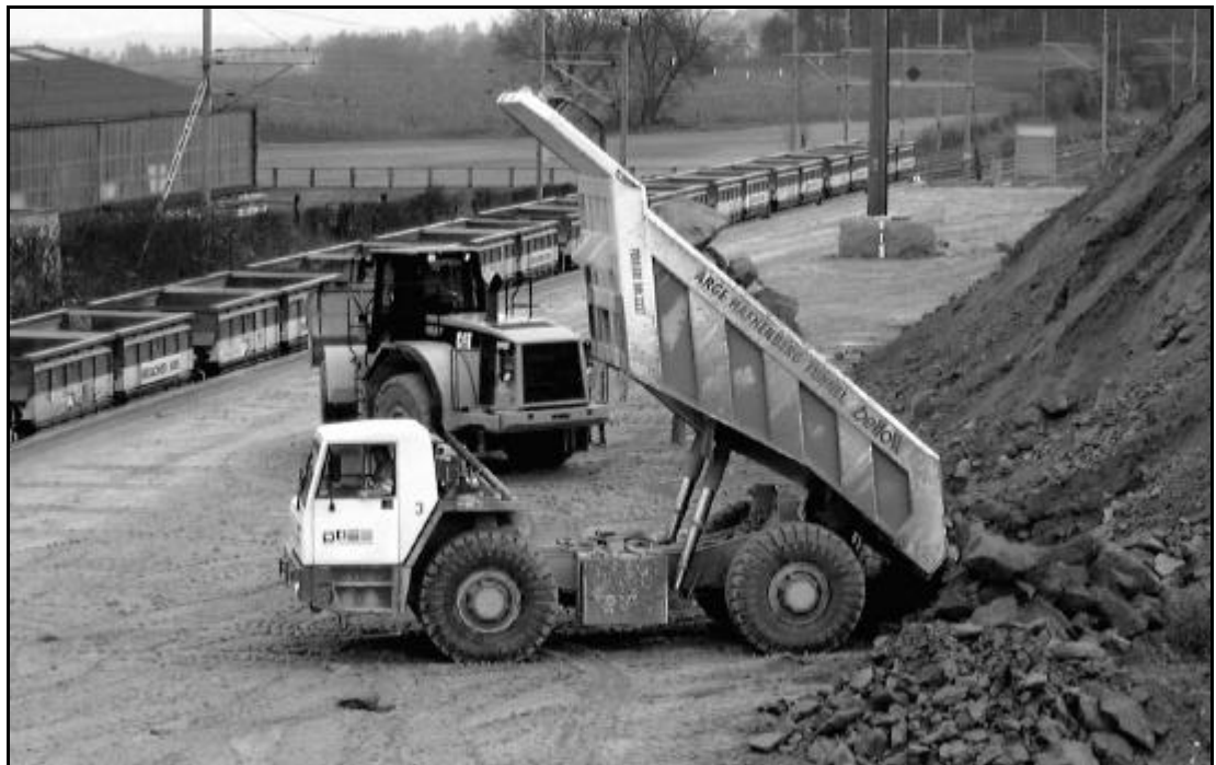
N4.1.20 Umfahrung Birmensdorf, Bahnverladeanlage Ristet
