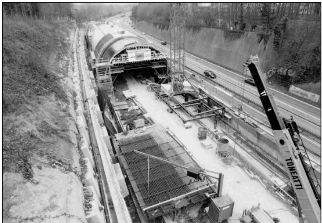
A3 Zürich-Chur, Überdeckung Entlisberg
