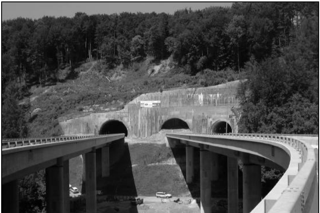
N20.1.4 Umfahrung Birmensdorf, Voreinschnitt Weiher mit Portalansicht Eggraintunnel und Ausfahrtstunnel Ristet (rechts) Im Vordergrund: Reppischtalbrücke
