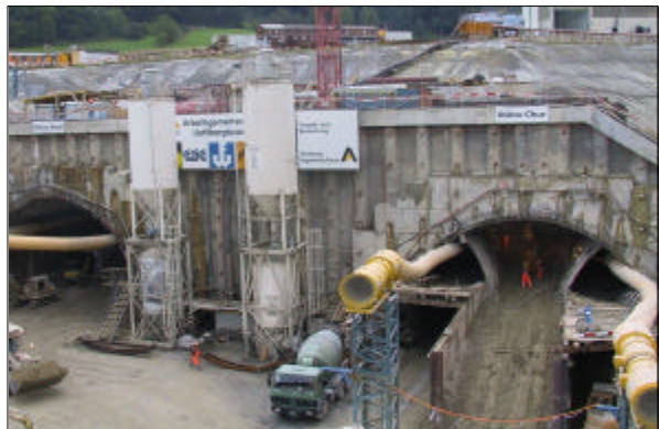
Baugrube Reppischtal (Portal Diebis, Stand September 2001)
