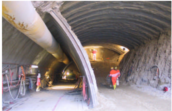
Oberer Paramentstollen und Kalotte mit Stahleinbau (Kernbauweise)
