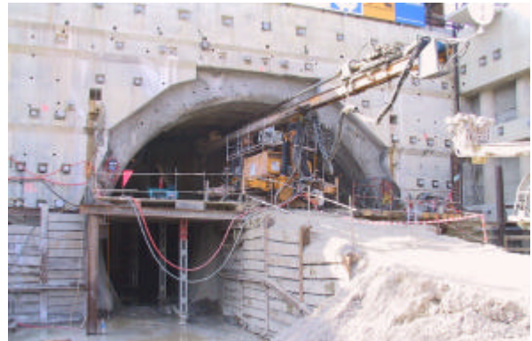
Bohren 2. Rohrschirmetappe
