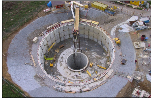
Abluftschaft und Baugrube für Kaminfundament
