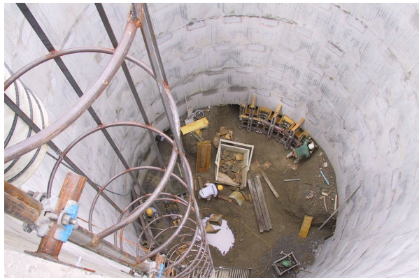
Schachtabteufen im Lockergestein (Unterfangungsbauweise)
